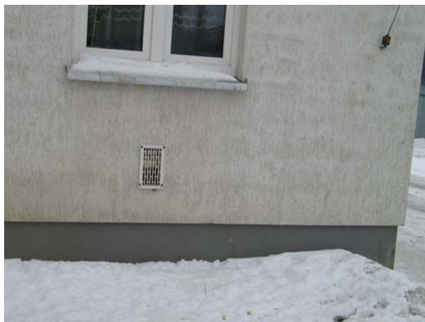
Ryc. 2. Zasłonięta kratka wentylacyjna w kuchni (od zewnątrz)
