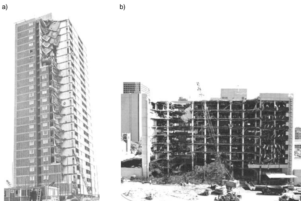
Ryc. 1. Katastrofy budynków: a) Ronan Point w Anglii, b) Alfred P. Murrah w Oklahomie
