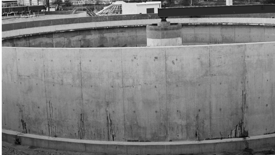
Rys. 36. Naprawa segmentu przez iniekcję Fig. 36. Repair of the segment by injection
