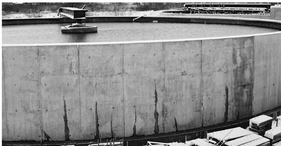
Rys. 35. Przecieki podczas próby szczelności Fig. 35. The leakage during testing of the tightness
