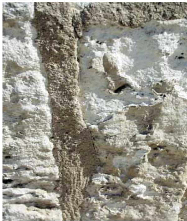
Rys. 18. Solne wykwyty na powierzchni wapienia
