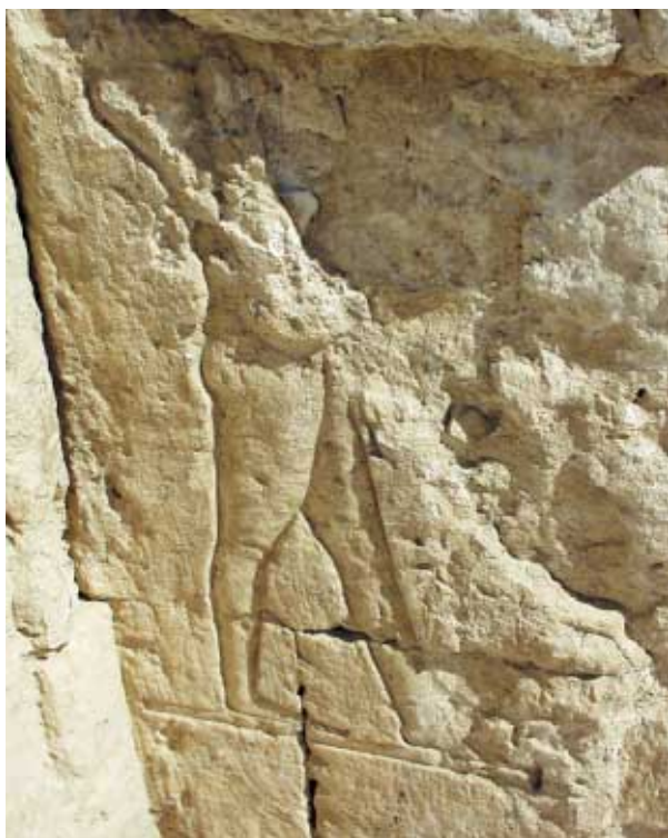
Rys. 19. Odsparowanie się wierzchniej, reliefowanej warstwy kamienia
