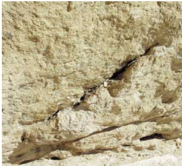
Rys. 20. Głębokie pęknięcia strukturalne
