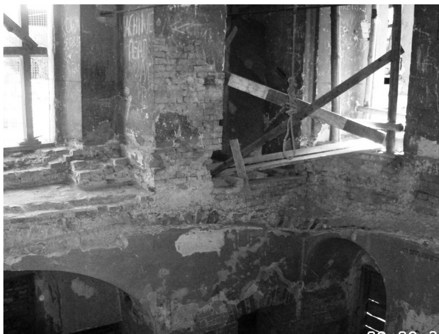
II. 1. Synagoga w Dąbrowie Tarnowskiej. Zalewanie wnętrza przez nieszczelności pokrycia dachu i przemieszczenie ściany frontowej doprowadziły do zniszczenia części sklepień nad parterem
