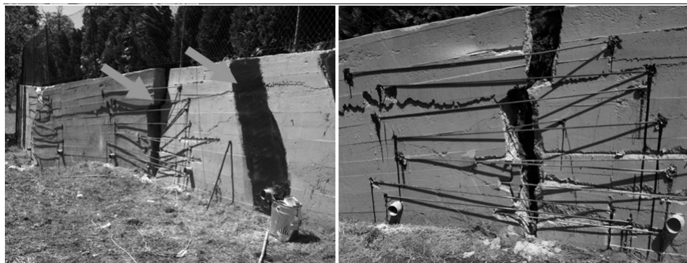
Rys. 2. Dwa systemy wzmacniające zdeformowany mur oporowy – po lewej, oraz widok układu prętów stalowych zszywających przełom w murze, wklejonych na polimerze PT – po prawej
