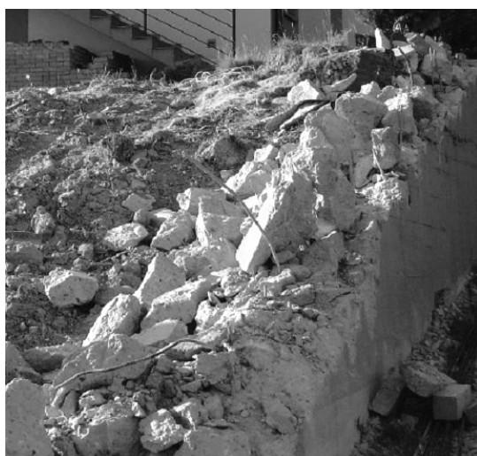
Rys. 8. Rozebrany fragment muru z widocznymi, rzadko rozmieszczonymi prętami zbrojenia
