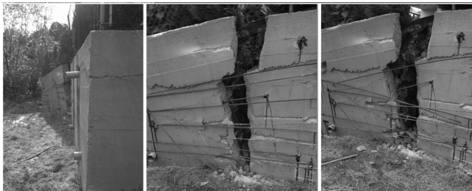
Rys. 5. Praca muru w stadium deformacji 2 tygodnie po awarii (2 pręty wyrwane) – po lewej i w środku, oraz końcowa faza pracy zespolenia przełomu przed rozebraniem muru – po prawej
