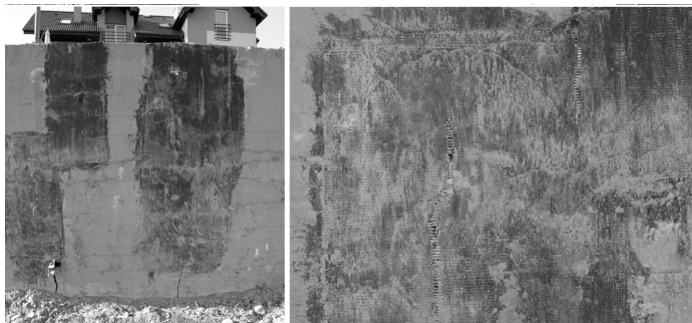
Rys. 7. Mata kompozytowa szklano-polimerowa – 2 tygodnie po aplikacji. Wzmocnienie wciąż spajało pęknięty mur pomimo lokalnie występujących uszkodzeń siatki szklanej
