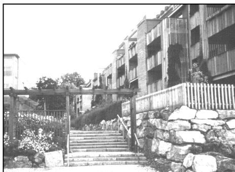
Il. 34. Skarpa terenowa kryje podziemne garaże, będąc równocześnie izolacją od ulicy
