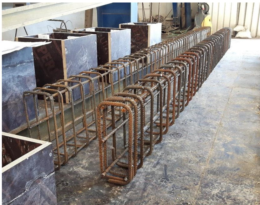
Rys. 4.28. Przygotowane szkielety zbrojenia belek
