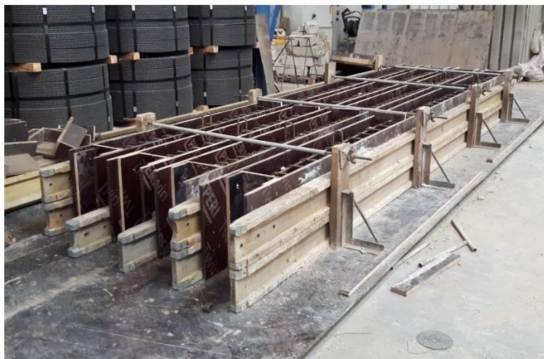
Rys. 4.30. Przygotowane do betonowania szalunki wraz z zamontowanym zbrojeniem i stalową blachą
