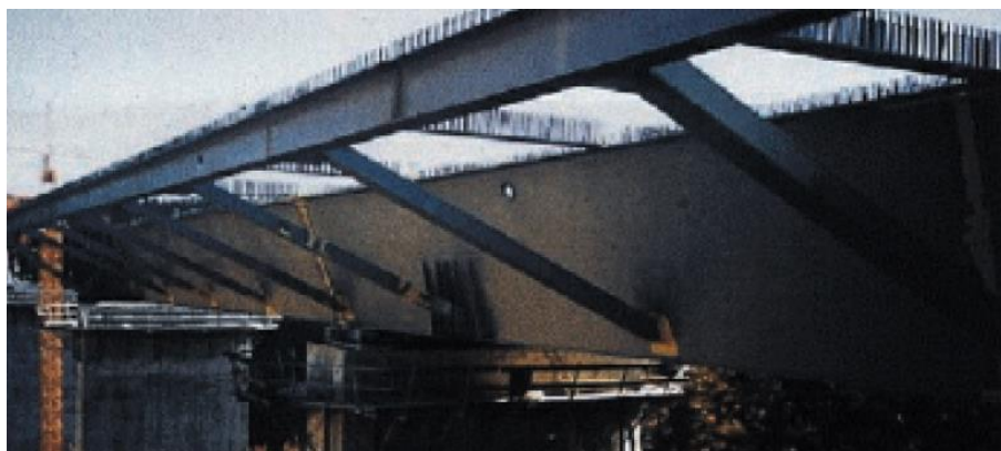
Rys. 2.3. Część wspornikowa mostu Wilde Gera z nowatorskim rozwiązaniem w postaci płyt zespolonych typu stalowa blacha-beton
