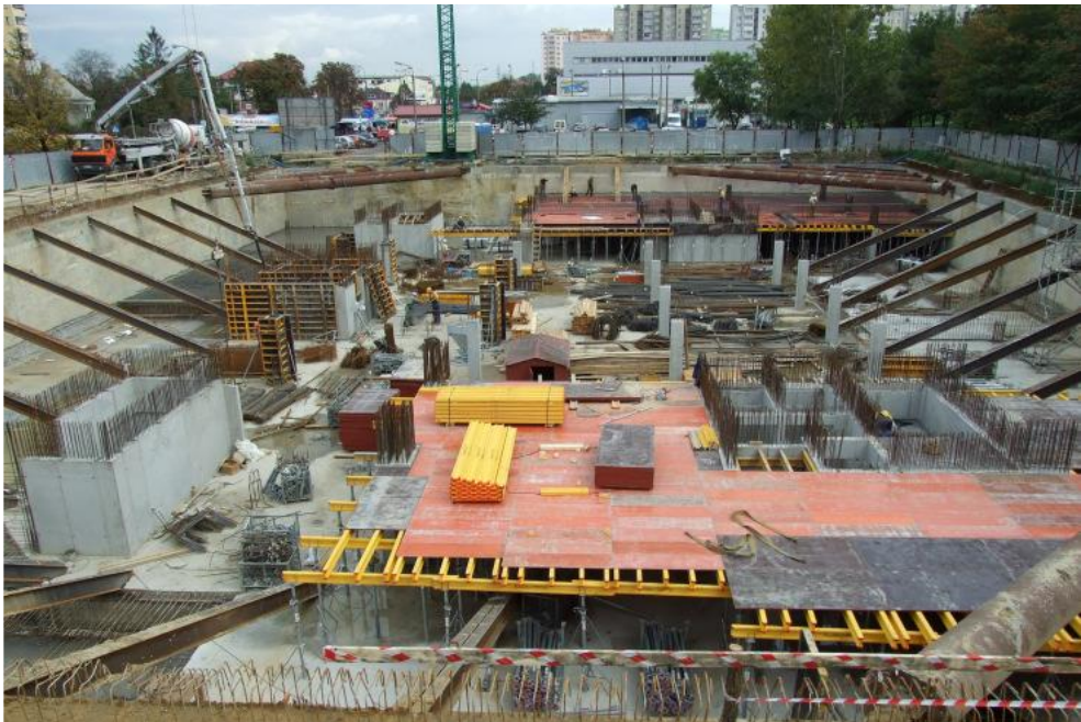
Rys. 2. Ściana szczelinowa z rozparciem ukośnym, materiały firmy Keller Polska
