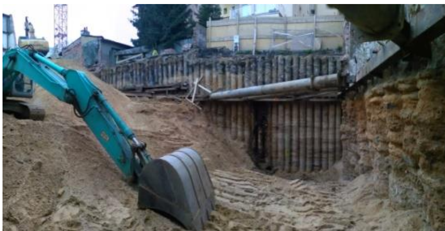
Rys. 10. Obudowa wykopu - budowa Hotelu Ferreus; w centralnej części palisada VDW; po prawej stronie zdjęcia – pale „jet-grouting”
