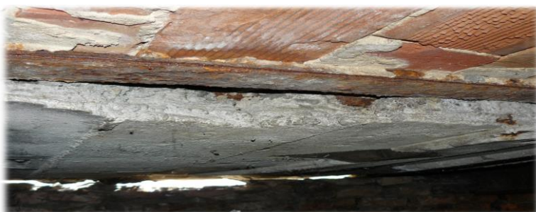
Fot. 3. Korozja belek stropowych – źródło: zbiory własne
