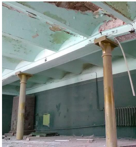
Rys. 4. Pozostawiona część oficyny; stropy odcinkowe wsparte na słupach żeliwnych
