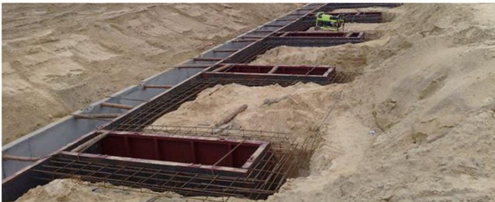
Rys. 4. Murki prowadzące, materiały firmy Keller Polska
