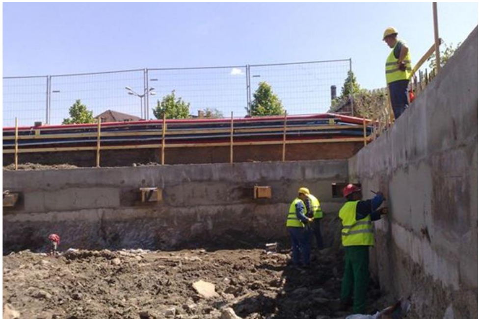
Rys. 1. Wspornikowa ściana szczelinowa, materiały firmy Keller Polska
