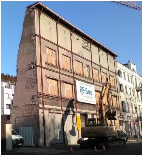
Rys. 3. Pozostawiona ściana frontowa zabytkowej kamienicy z zamontowanym rusztem stalowym
