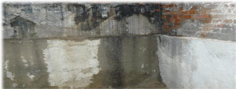
Fot. 2. Zawilgocenie ścian piwnic – źródło: zbiory własne
