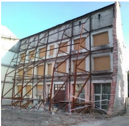
Rys. 7. Pojedynczy segment zabezpieczenia ściany frontowej budynku przy ulicy Kopernika 6 w Krakowie ( Hotel Ferreus – projekt budowlany, projekt wykonawczy, Pracownia Inżynierska Czesław Hodurek )
