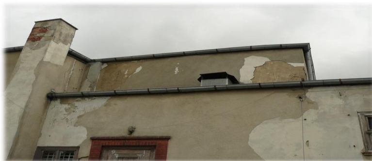
Fot. 5. Odpryski tynku, zawilgocenie ścian – źródło: zbiory własne
