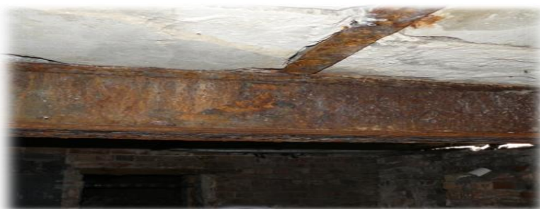
Fot. 4. Korozja stalowych podciągów – źródło: zbiory własne
