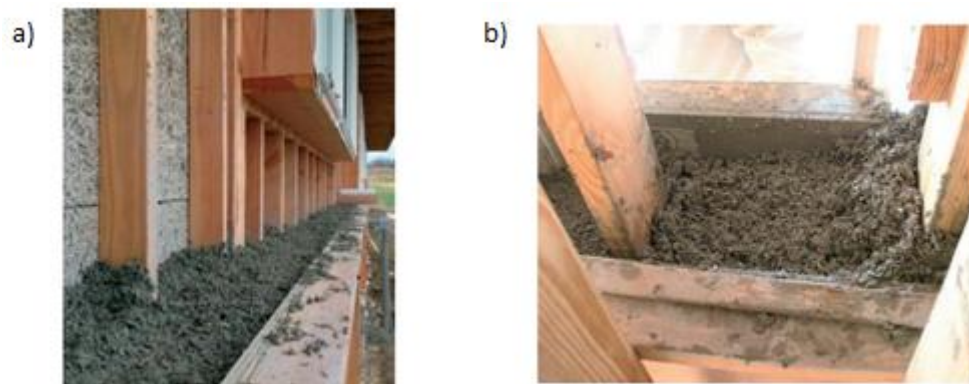
Rys. 6. Przegroda a) z zastosowaniem jednostronnego traconego deskowania, b) z zastosowaniem tymczasowego deskowania
