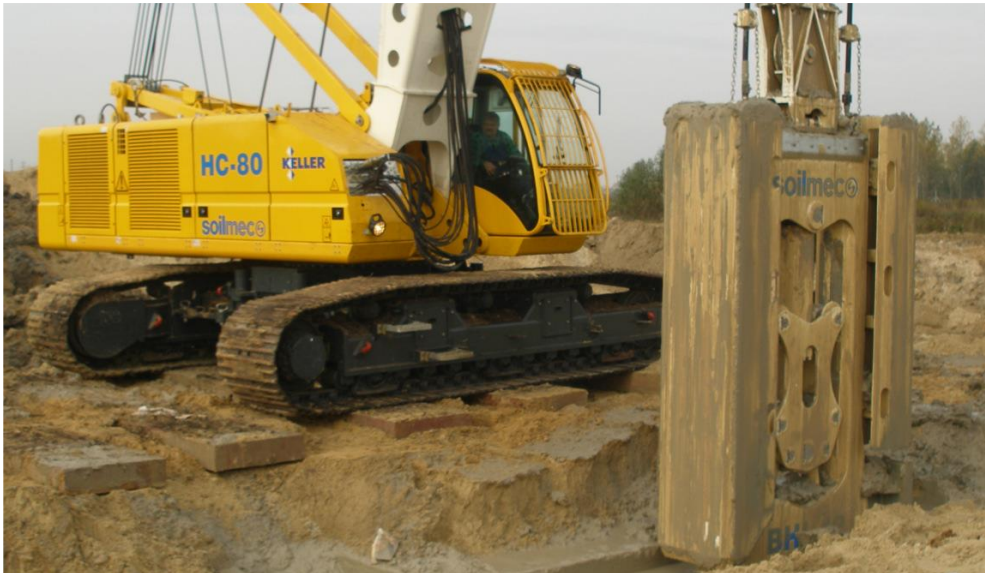
Rys. 3. Przygotowana platforma robocza, materiały firmy Keller Polska
