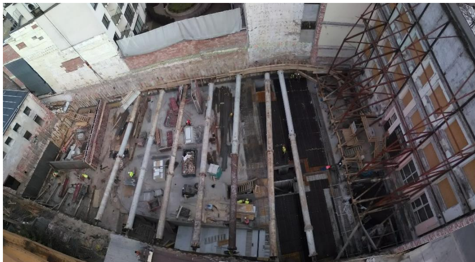
Rys 11. Rozpory wykopu na budowie Hotelu Ferreus
