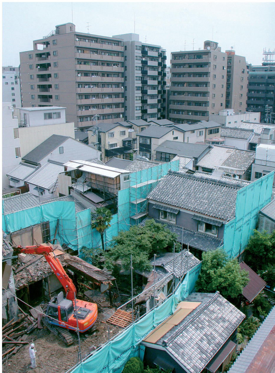
Fot. 7. Operacja wyburzania machiya (zdjęcie dzięki uprzejmości: Kyoto Center for Community Collaboration, „Machiya Revival in Kyoto”, s. 48)
