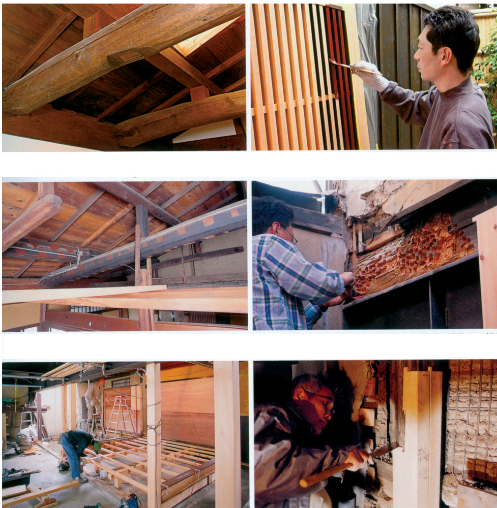
Fot. 8. Konserwacja drewnianej konstrukcji machiya tradycyjnymi metodami (zdjęcia dzięki uprzejmości: Kyoto Center for Community Collaboration, „Machiya Revival in Kyoto”, s. 21)
