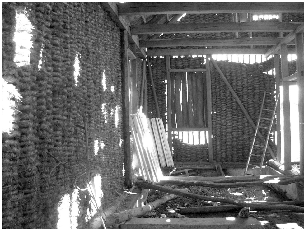
II. 4. Wnętrze nieukończonego domu o strychulcowej konstrukcji ścian przy ul. Wola 9 w Rudce, zbudowanego w latach 60. przez Albina Malinowskiego (fot. J. Szewczyk, 2007)
