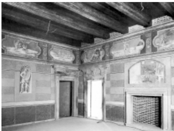
Ryc. 9. Zrekonstruowany strop drewniany w komnacie 1. piętra Fig. 9. Reconstructed wooden ceiling in a first floor chamber
