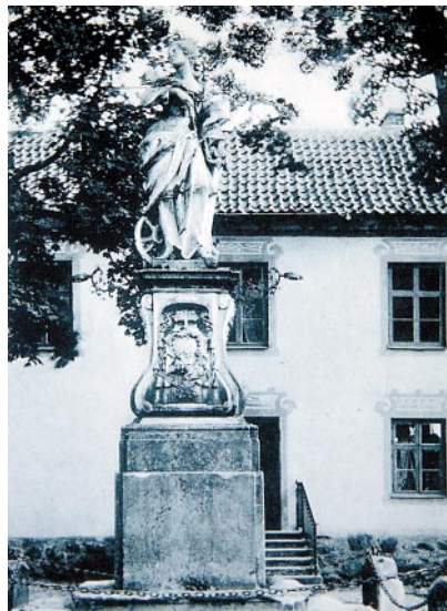
Ryc. 39. Pomnik św. Katarzyny na tle skrzydła południowego ok. 1908 r. Wokół okien skrzydła południowego widoczne malowane opaski. Fot. wg Festschrift 1908, ze zbiorów Muzeum Warmii i Mazur w Olsztynie
