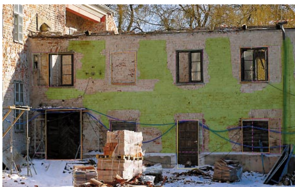
Ryc. 27. Południowy odcinek elewacji zachodniej skrzydła zachodniego (z fazy II) po skuciu tynków. Nad bramą wjazdową (z fazy IV) widoczny ślad po poprzedzającym ją pierwotnie budynku bramnym. W prawym dolnym narożniku otwory okienne najwyższej kondygnacji: mniejszy – gotycki z fazy II, większy – z fazy V, z wręgami po deskowym nadprożu. Fot. L. Wawrykiewicz, 2010 Fig. 27. The southern section of the west elevation of the west wing (from phase II) after hacking off plaster. Over the entrance gate (from phase IV) visible traces of the preceding original gatehouse. In the bottom right corner window openings of the top storey: the smaller – Gothic from phase II, the larger – from phase V, with traces of plank lintel. Photo by L. Wawrykiewicz, 2010
