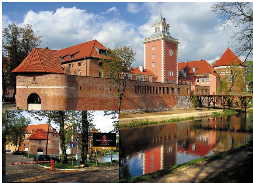
Ryc. 40. Przedzamcze w widoku od południowego zachodu po adaptacji na Hotel Krasicki. U dołu wjazd do zamku zamieniony na parking. Fot. L. Wawrykiewicz, 2011
