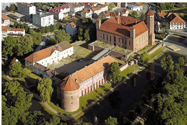
Ryc. 2. Zamek rezydencjonalny biskupów warmińskich w Lidzbarku Warmińskim wraz z przedzamczem południowym (przed przebudową) oraz młynem w miejscu przedzamcza północnego – widok z lotu ptaka. Fot. Wojciech Wójcik, 2008
