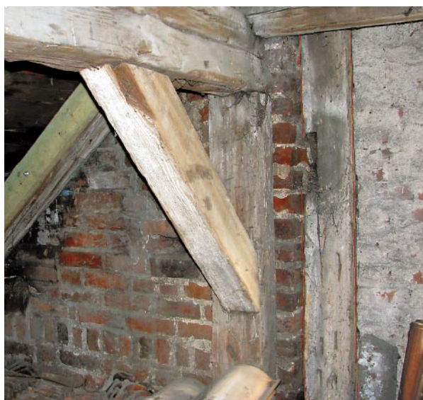
Ryc. 10. Poddasze wieży z widocznymi relikwiami słupów gotyckiej konstrukcji dachu Fig. 10. Tower loft, with visible relics of posts of the Gothic roof construction
