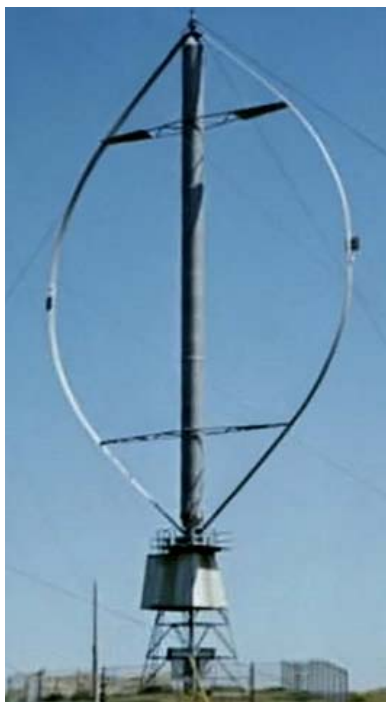
Ryc. 1. Wirnik Darrieusa Fig. 1. Darrieus rotor
