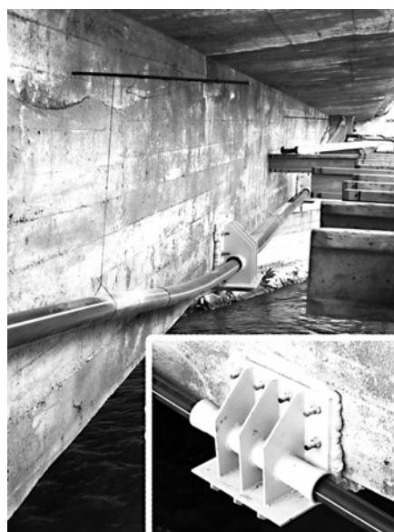
Fot. 4. Dewiator stalowy przęsłowy Photo 4. Span steel deviator
