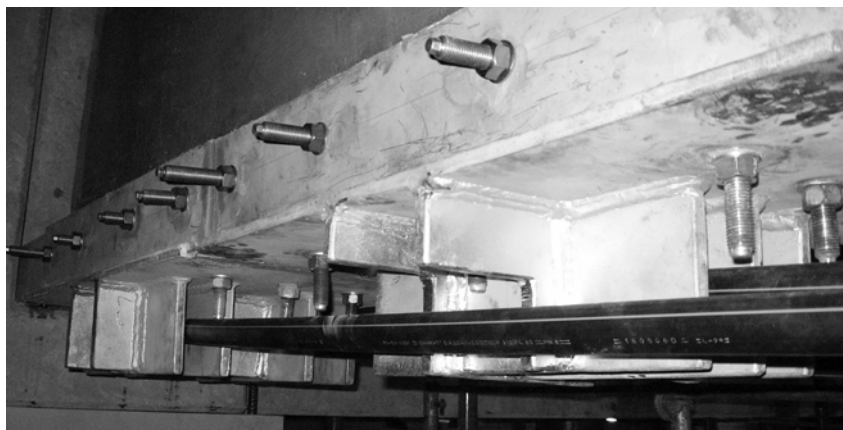
Fot. 6. Zakotwienie bierne Photo 6. Blind end anchorage
