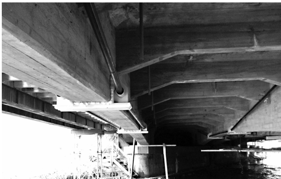
Fot. 1. Widok kabli sprężających wraz z dewiatorami stalowymi Photo 1. View of prestressing tendons and steel deviators
