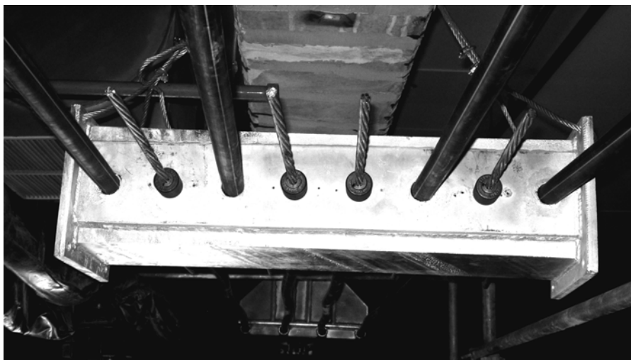
Fot. 8. Zakotwienie czynne Photo 8. Jacking anchorage
