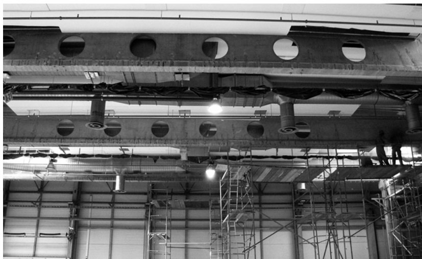
Fot. 5. Widok dźwigarów – z licznymi śladami po iniekcji rys Photo 5. Girders view – with pattern cracks after injection
