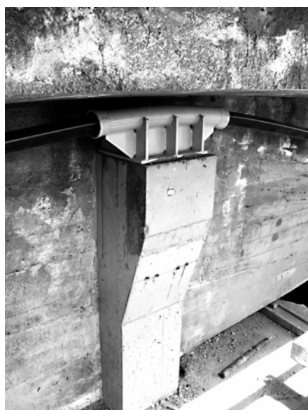
Fot. 3. Dewiator na pilastrze betonowym Photo 3. Deviator at concrete pilaster
