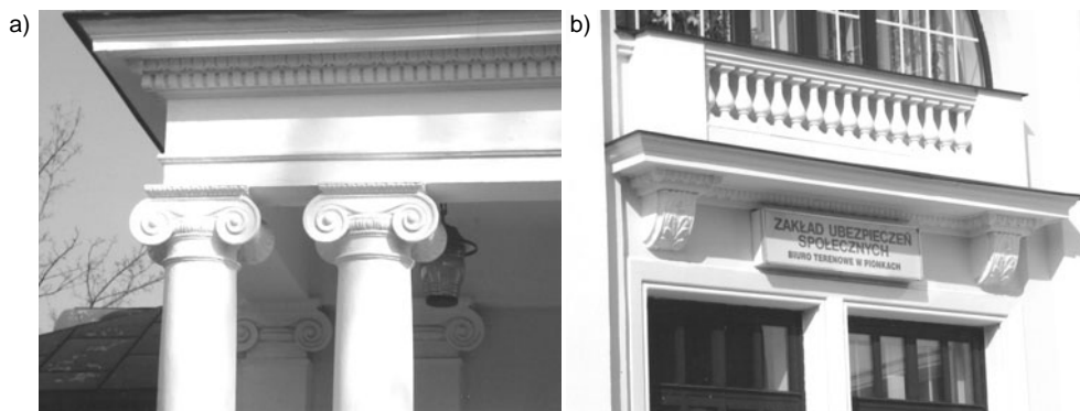
Fot. 14. Piękno architektury klasycznej – detale. Pałacyk „Pod Łabędziami” (M9) dyrektora technicznego PWP Pionki, autor projektu: inż. arch. E. Czyż, budowa w latach 1929–1930. Detale głowic jońskich i belkowania podtrzymującego płytę balkonu–tarasu. Detal okna nad wejściem, balustrady, półki i kroksztynów
