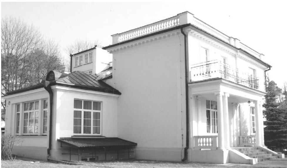
Fot. 12. Pałacyk „Pod Łabędziami” (M9) dyrektora techn. PWP Pionki, autor: inż. arch. E. Czyż, budowa 1929–1930: elewacja ogrodowa z prawej schody i taras związane z salonem, na I piętrze balkon i pokój chłopców (2 okna), okno narożne pokoju gościnnego, z lewej okna jadalni, pod nią pokój dla służby z oknem w fosie (daszek nad fosą „wynalazkiem współczesnym”)
