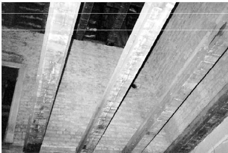
Rys. 4. Odsłonięte belki stropu drewnianego nad salą I piętra
