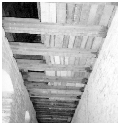
Rys. 5. Odsłonięte belki stropu drewnianego nad korytarzem
