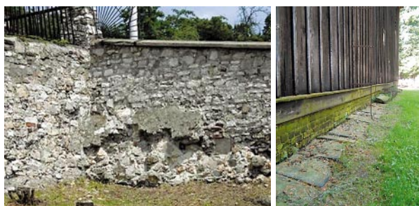
Ryc. 13. Przykłady uszkodzeń z powodu niewłaściwego użytkowania: a) mur ogrodzeniowy kościoła pw. Trójcy Świętej w Będzinie; b) otoczenie kościółka pw. św. Marcina w Ćwiklicach (zdjęcia: autor) Fig.13. Examples of damage caused by improper use: a) the fence wall of the Holy Trinity Church in Będzin; b) surroundings of the St. Martin Church in Ćwiklice (photos: author)
