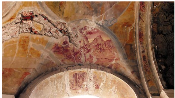
Ryc. 5. Uszkodzone sklepienie sanktuarium w Świętej Lipce (zdjęcie: Szymon Konecko z Pracowni Konserwacji Zabytków STIUK w Olsztynie) Fig. 5. Damaged vault of the Sanctuary in Święta Lipka (photo: Szymon Konecko from the Monument Conservation Laboratory STIUK in Olsztyn)
