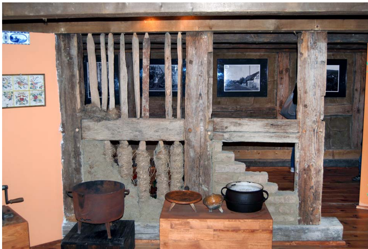
Ryc. 6. Ekspонат pokazujący metody wypełniania ścian budynków w konstrukcji szkieletowej – archiwum autora
