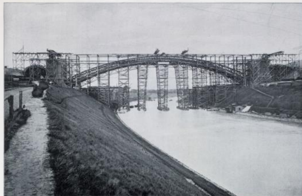
Abb. 294. Blickseite bei Lennau. Aufbau des ersten Ueberbaus. August 1904.
