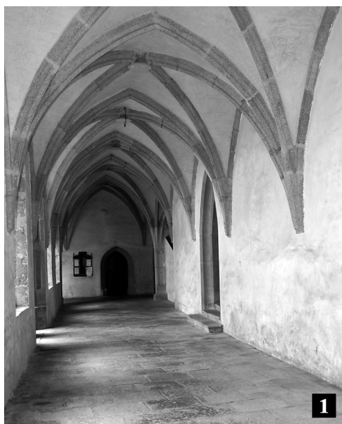
Il. 13. Sposób wyprowadzenia żeber sklepiennych: 1 – krużganek południowy klasztoru Vyšši Brod, 2 – krużganek południowy klasztoru Zlata Koruna. Fot. E. Łużyniecka
