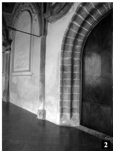
Il. 13. Sposób wyprowadzenia żeber sklepiennych: 1 – krużganek południowy klasztoru Vyšši Brod, 2 – krużganek południowy klasztoru Zlata Koruna. Fot. E. Łużyniecka
