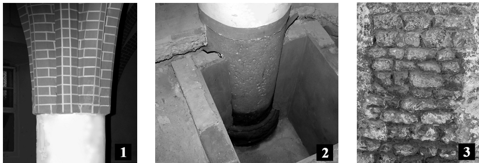
Il. 10. Fraternia w skrzydle wschodnim: 1 – wyprowadzenie żeber, 2 – baza słupa, 3 – budulec ściany zachodniej. Fot. E. Łużyniecka
