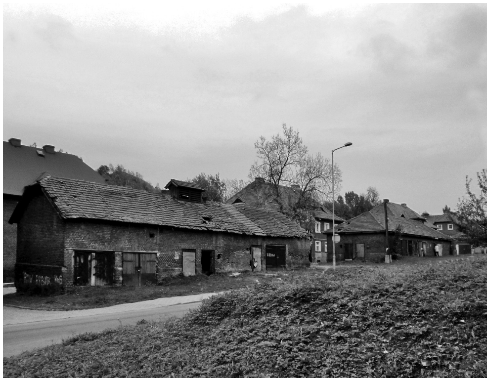
II. 4. Rybnik, Niedobczyce, dawna kolonia Römergrube, widok na zabudowę mieszkalną i budynki gospodarcze (foto K. Łakomy, 2012)
