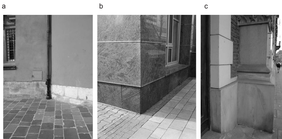
II. 3. Cokół: a – zrównany, b – cofnięty, c – wysunięty
