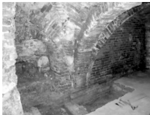
Ryc. 6. Klasztor cystersów w Jędrzejowie, cellarium pod refektarzem, ściana zachodnia z widocznym – częściowo zamurowanym wlotem do urządzenia piecowego. Fot. A. Bojęś-Białasik, 2009 Fig. 6. The Cistercian monastery in Jędrzejów, cellarium under the refectory, the west wall with a visible, partially walled-in opening to the stove-like device. Photo: A. Bojęś-Białasik, 2009
