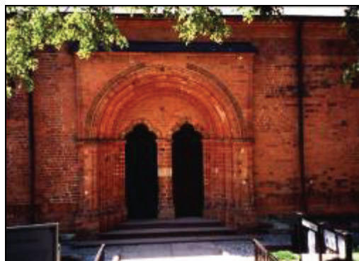
Rys. 10. Główne wejście do kościoła św. Jakuba w Sandomierzu (XIII w.); fot. I. Płuska Fig. 10. Main entrance to the 13th c. St. Jacob's Church in Sandomierz (Poland); photo I. Płuska
