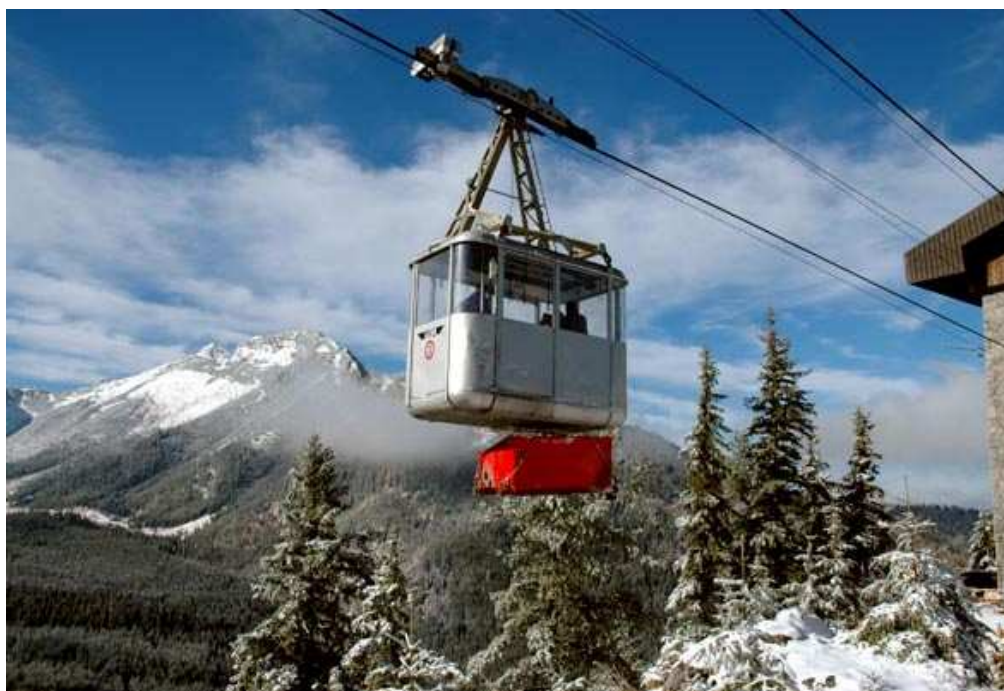
Il.80. Tatry Polskie. Kolej linowa na Kasprowy Wierch przed remontem w latach 2006-2007. Źródło: Internet, wrzesień 2008, http://www.skionline.pl/stacje/index.php?co=newsy&id_newsa=5046
