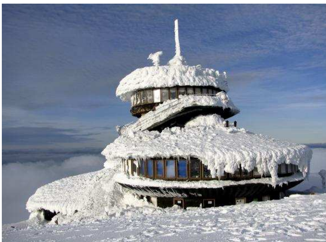
Il. 149. Karkonosze. Śnieżka. To wiatr – według hipotez – spowodował uszkodzenia w obserwatorium na Śnieżce. W budynku popękały ściany, sufit oraz podłoga. Źródło: Internet, marzec 2009, http://www.dziennik.pl/foto/article342563/Katastrofa_na_Sniezce.html
