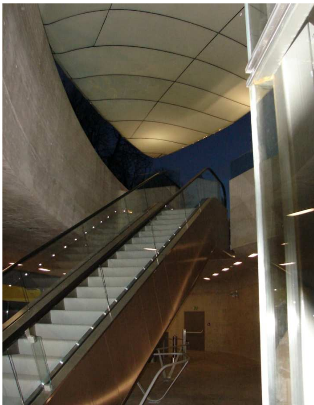
Il. 125. Alpy austriackie. Innsbruck. Kolej Nordpark – Wnętrze stacji na zboczu góry Nordkette – Alpenzoo Station, fot. Przemysław Kowalski, Wydział Architektury Politechniki Krakowskiej, Pracownia Projektowania Architektury Krajobrazu
