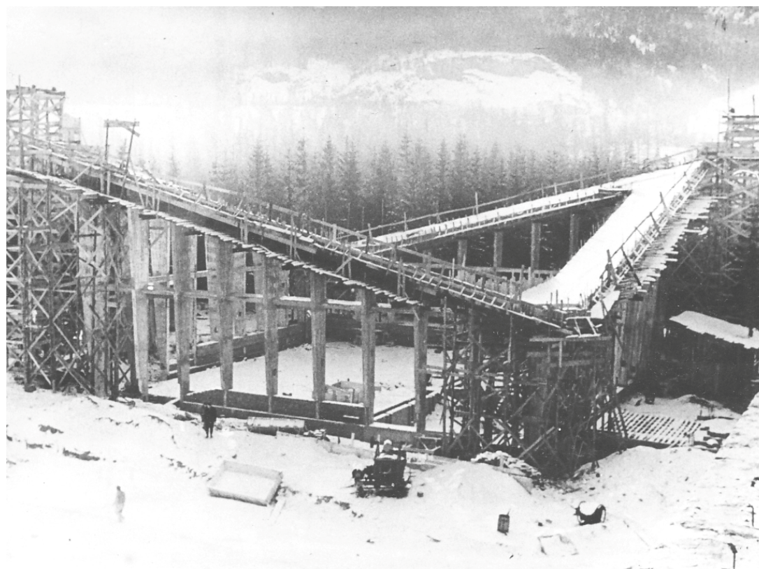
Il.57. Andrzej Skoczek. Hala sportowa w Zakopanem w budowie. Źródło: A. Skoczek, O niektórych parametrach architektonicznych kształtowania dachów wiszących w środowisku Podhala , maszynopis niepublikowany, Kraków 1961
