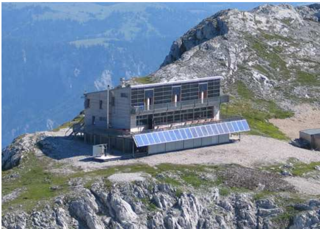
Il. 141. Alpy Austriackie. Schronisko Hochschwab 2250 m n.p.m. Naturalne materiały w połączeniu z nowoczesnymi technologiami tworzą nowy wymiar architektury górskiej. Źródło: Internet, listopad 2007: www.presse.hausderzukunft.at/.../Bildmaterial/
