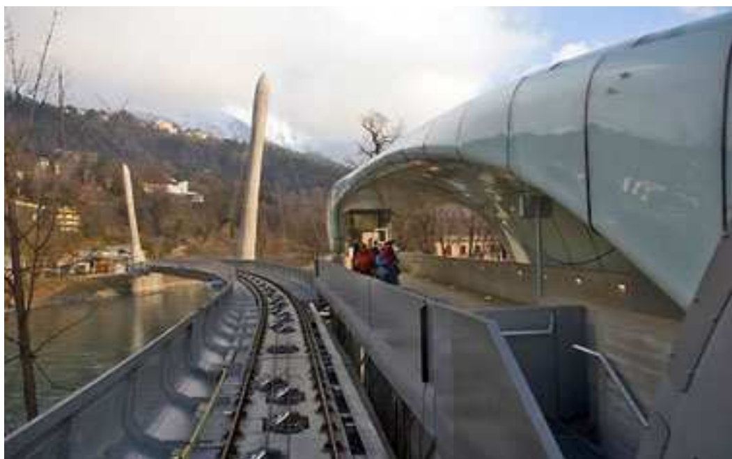
Il.123. Alpy austriackie. Innsbruck. Kolej Nordpark – Stacja pośrednia – Loewenhaus Station. Źródło: Internet, luty 2012 r., http://www.arcspace.com/architects/hadid/nordpark/nordpark.html
