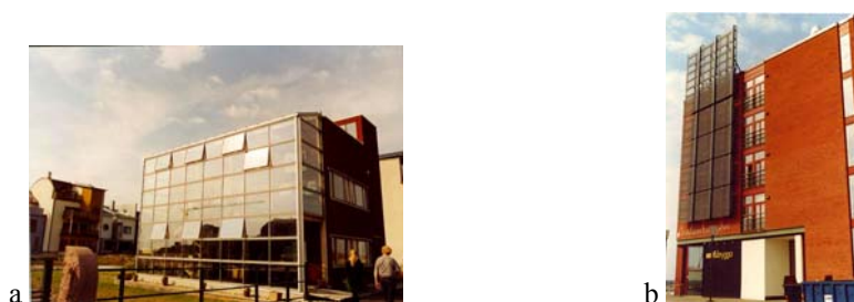
Ryc. 5. Architektura eksponująca: a) ogrody zimowe, b) aktywne systemy słoneczne – zespół mieszkaniowy Bo 01 „City of Tomorrow”, Malmö, Szwecja. Fot. autorka
