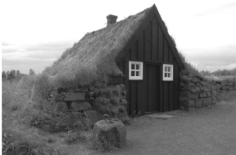
Il. 8. Budynek z ziemi, mieszczący kuźnię, zrekonstruowany w skansenie Árbæjarsafn (fot. M. Motak)
