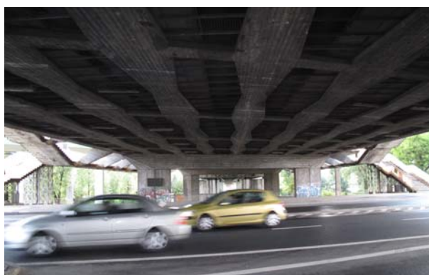
Rys. 6. Konstrukcja niosąca przęsa praskich „czterdziestek” w ciągu Trasy Łazienkowskiej Fig. 6. Load-bearing structure of Prague “forties” within the line of Łazienkowska Route in Warsaw
