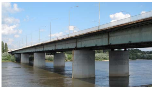
Rys. 3. Widok ogólny Mostu Łazienkowskiego w Warszawie (B. Rymsza)
