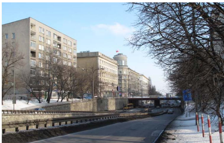
Rys. 1. Dwupoziomowe skrzyżowanie Trasy Łazienkowskiej z ul. Marszałkowską w Warszawie (fot. B. Rymśza)
