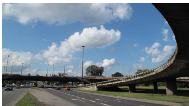
Rys. 7. Estakady węzła warszawskiego w ciągu Trasy Łazienkowskiej w Warszawie (B. Rymsza) Fig. 7. Viaduct of Warsaw interchange within the line of Łazienkowska Route in Warsaw
