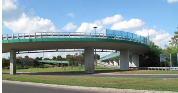
Rys. 8. Estakady węzła praskiego w ciągu Trasy Łazienkowskiej w Warszawie (B. Rymśza) Fig. 8. Viaduct of Prague interchange within the line of Łazienkowska Route in Warsaw
